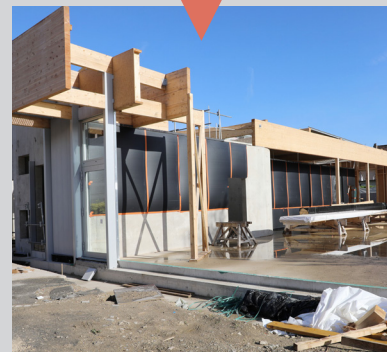
Construction de la Cuisine centrale (voir p.42)
