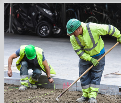
Reprise et réfection des voiries communales
